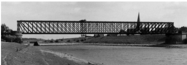
De monumentale spoorwegbrug over een dode arm van de Rijn bij Griethausen. De brug maakt deel uit van de in 1865 aangelegde treinverbinding tussen Zevenaar en Kleef. Tot 1982 is de brug nog in gebruik geweest voor goederenvervoer.
