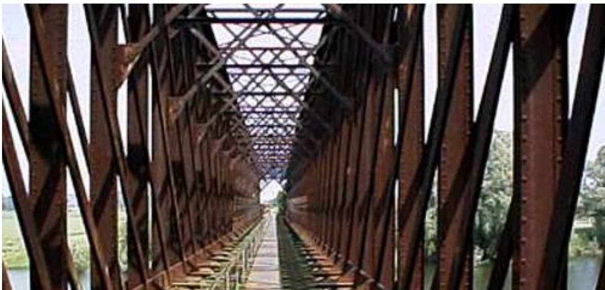
Ondanks de zorgelijke staat van onderhoud is de voormalige spoorwegbrug bij Grieterort nog steeds stabiel en begaanbaar.
